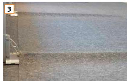
Über die ausgerichteten Ausleger wird eine Faserschutzmatte BauderGREEN FSM verlegt.
