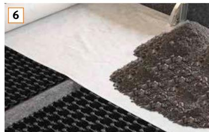
Ein entsprechendes Drän-, Speicher- oder Retentionselement wie z.B. das BauderGREEN RE 40 wird zwischen die Ausleger und in der Fläche verlegt. Ein Filtervlies z.B. BauderGREEN FV 125 und das BauderGREEN SUB-EM 1250 machen das System komplett. Das war's!
